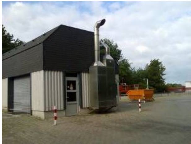
Local dégrilleurs – 2 000 m 3 /h
