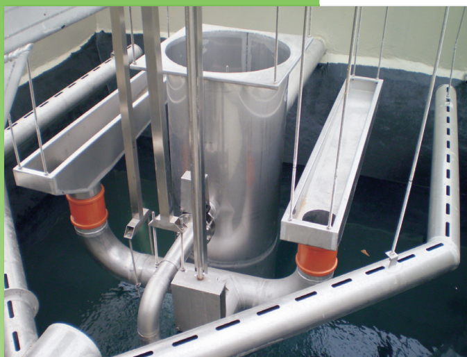
Technologie du réservoir clarificateur secondaire
